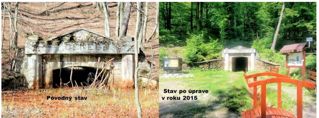
Obr. 13 . DĚNES štôlna s kalom pred portálom a po úprave
